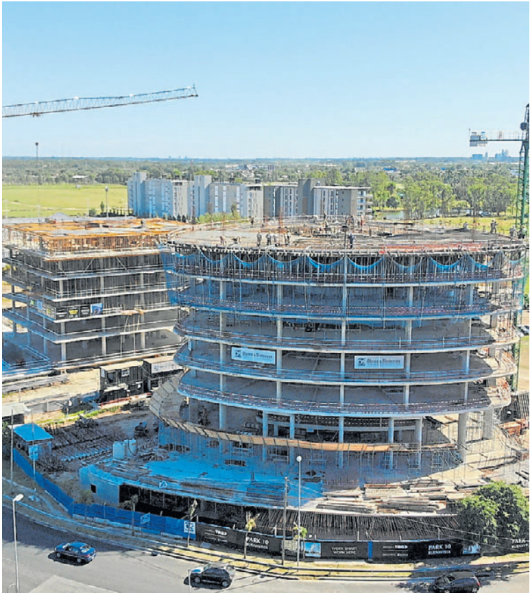
OFICINAS. Park 10 Buenavista, proyecto del Estudio Urgell Penedo Urgell y construcción a cargo de Obras & Sistemas.,
