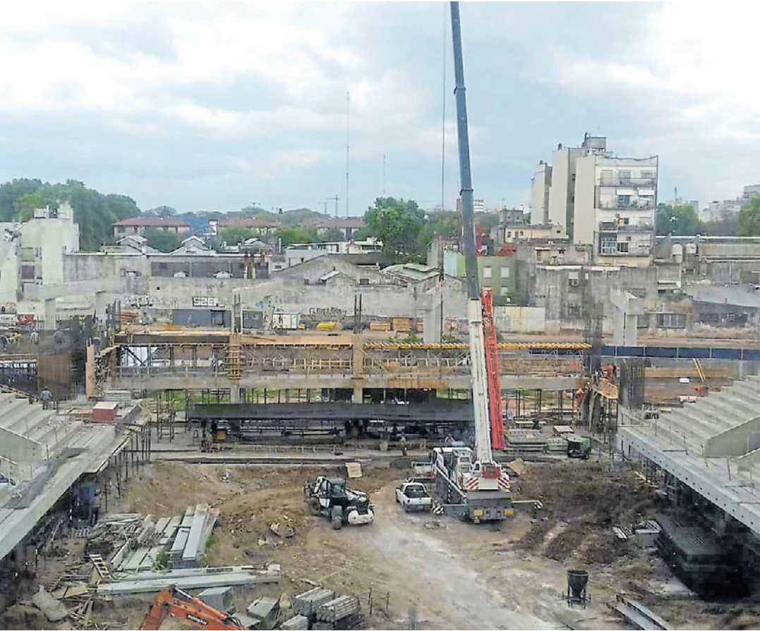
MOVISTAR ARENA. La obra en la que llegaron a trabajar 700 personas simultáneamente fue terminada antes de lo previsto, aún respetando horarios limitados de trabajo para evitar molestias a vecinos.
