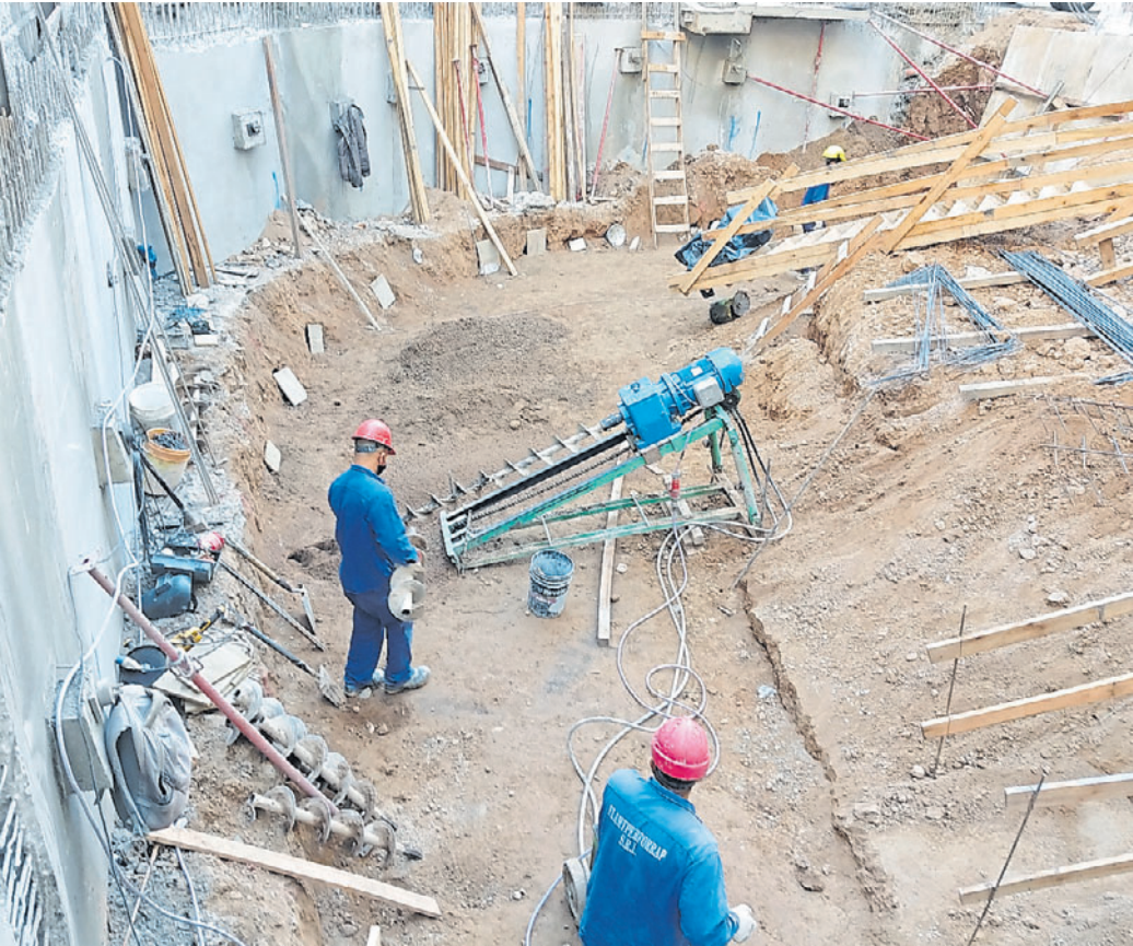
EXCAVACIÓN. La empresa es pionera en el empleo de anclajes de tracción, un sistema que aporta mayor seguridad en las tareas de submuración.
