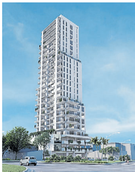
ALARIF TRENCH. Sobre un terreno de 640 metros cuadrados.
