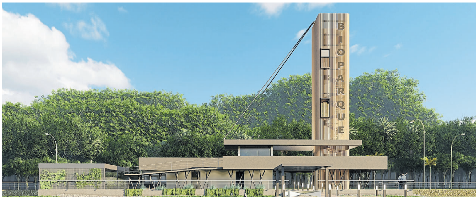
FARO. El edificio del Bioparque, un hito del lugar.
