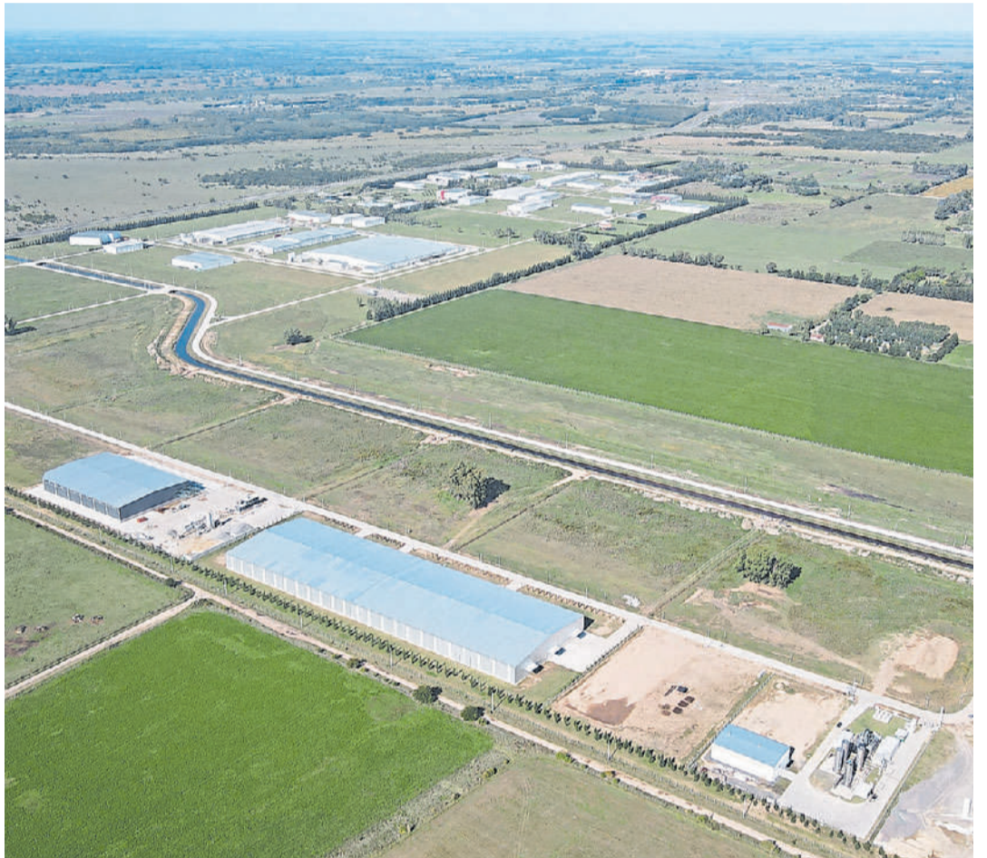
NUEVA ETAPA. Completará 200 hectáreas dedicadas a la industria y el trabajo sobre la Ruta 6
