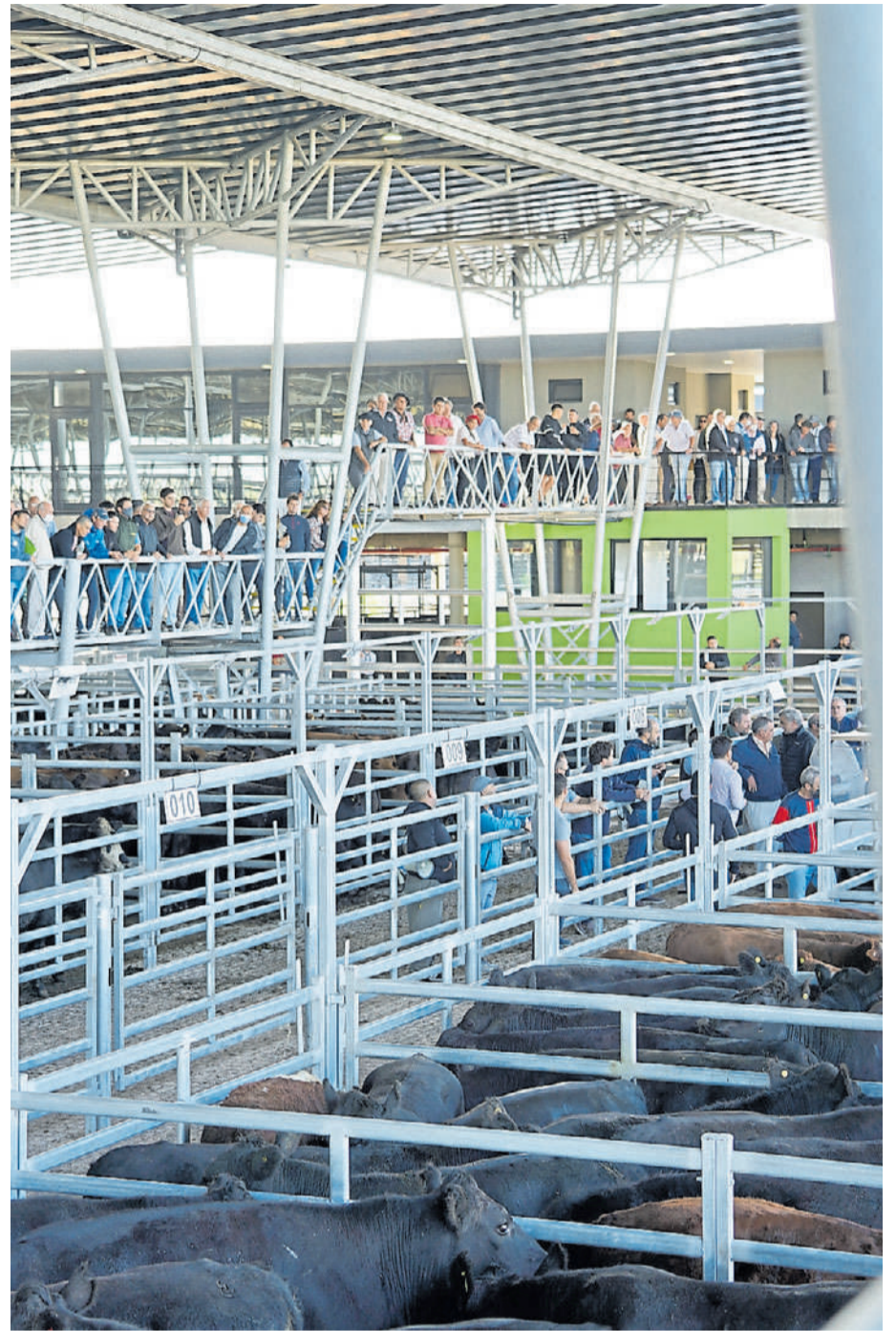
ALTA PRESTACIÓN. La estructura del Mercado, de acero galvanizado.
