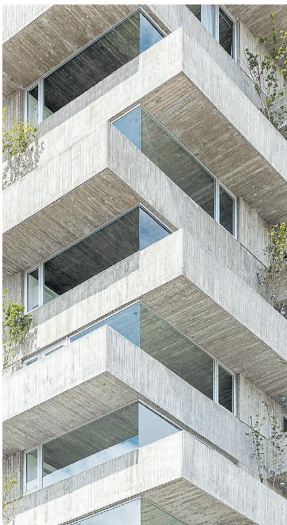
**ESTRUCTURA.** Evita la columna de esquina y permite un juego de vacíos y llenos.
