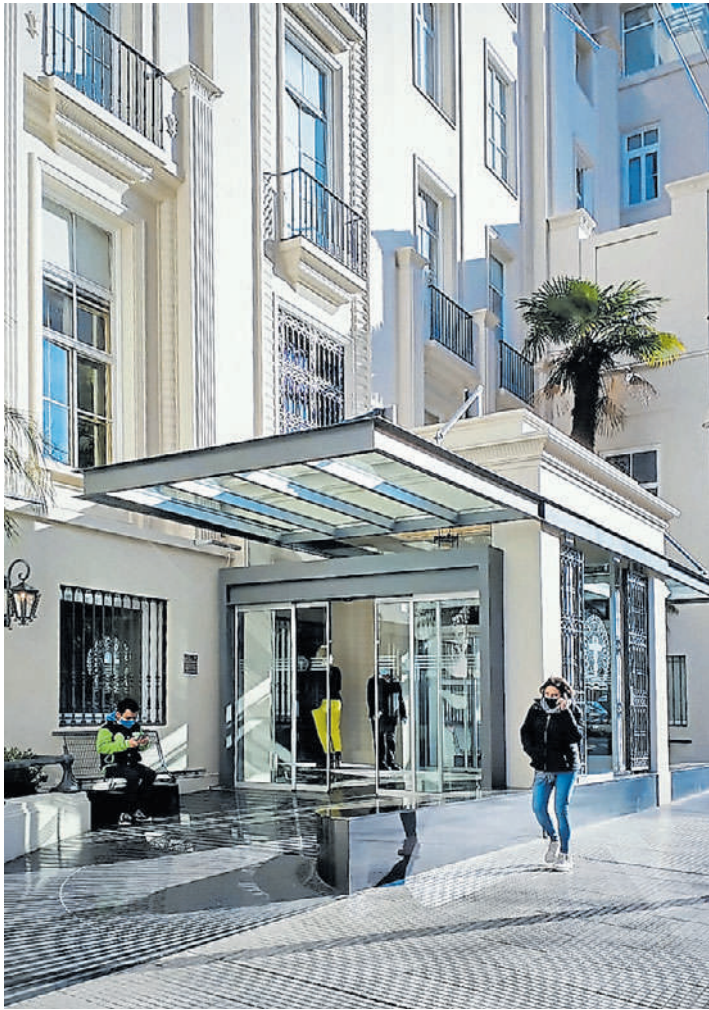
SANATORIO OTAMENDI. Restauración de la fachada histórica.
