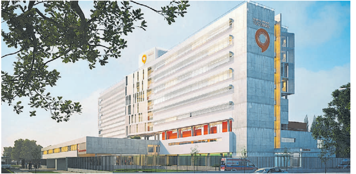
HOSPITAL PRIVADO DE TUCUMAN. Centro de alta complejidad en la periferia de la capital provincial.
