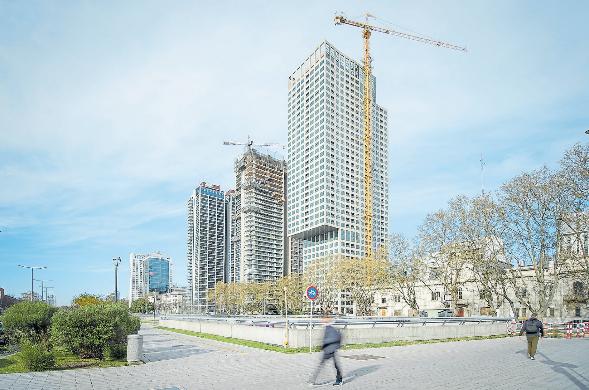
DECISIÓN. El sistema tradicional de hormigón armado se adaptó a las exigencias del proyecto tanto por su altura como por los requerimientos estéticos y funcionales.
