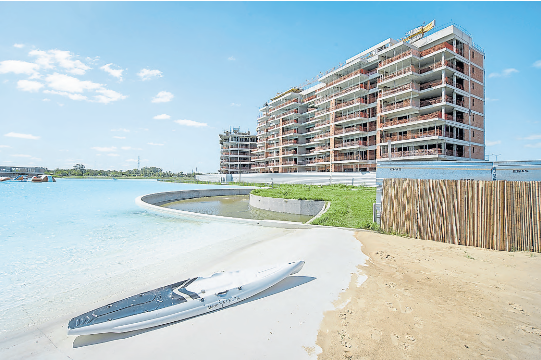
DESAFÍO. La planificación y ejecución del sistema de excavación, contención y fundaciones.
