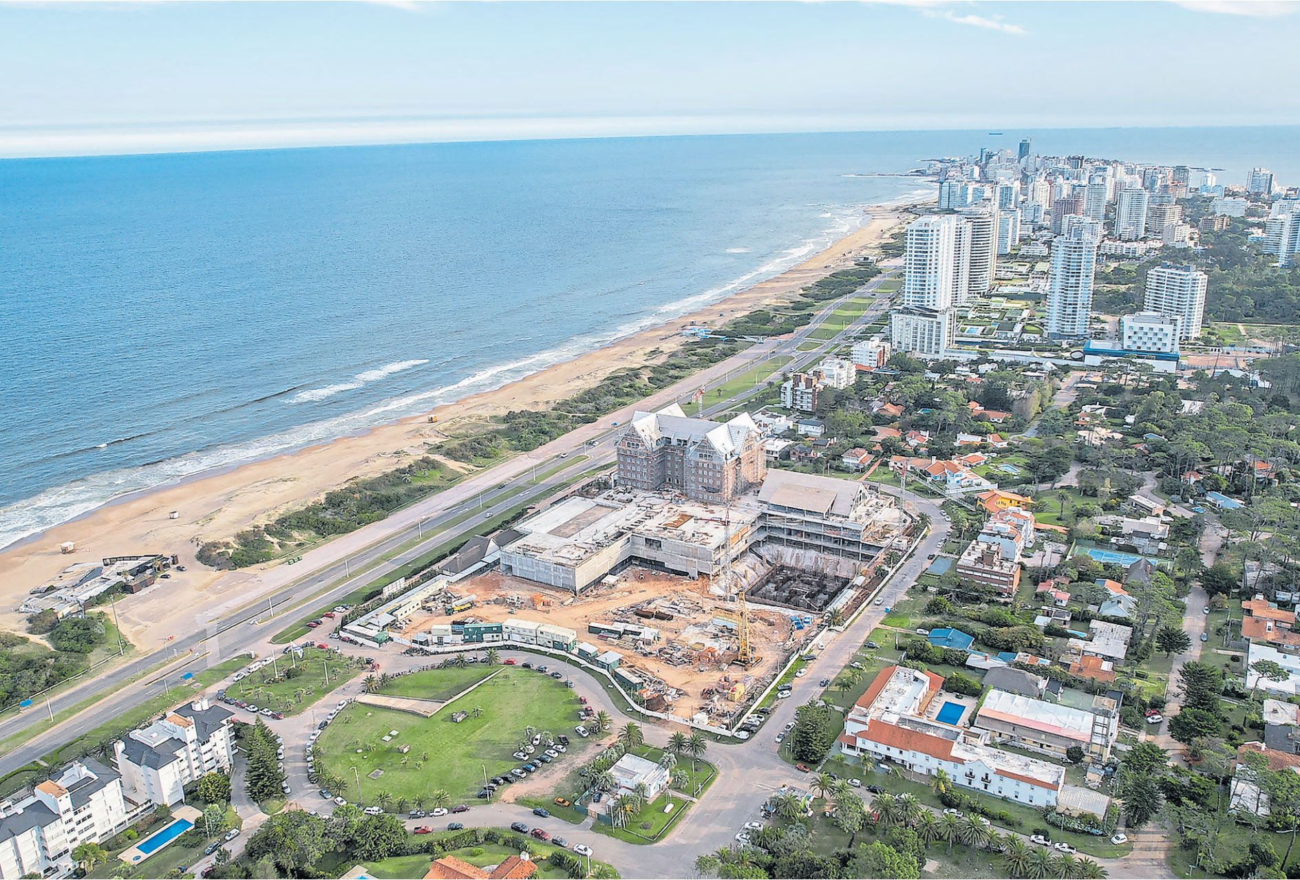
RECUPERAR Y CONSTRUIR. Hoy, el hotel se encuentra en etapa de obra gruesa de albañilería e instalaciones; mientras que las fundaciones de la Torre 1 están en ejecución.
