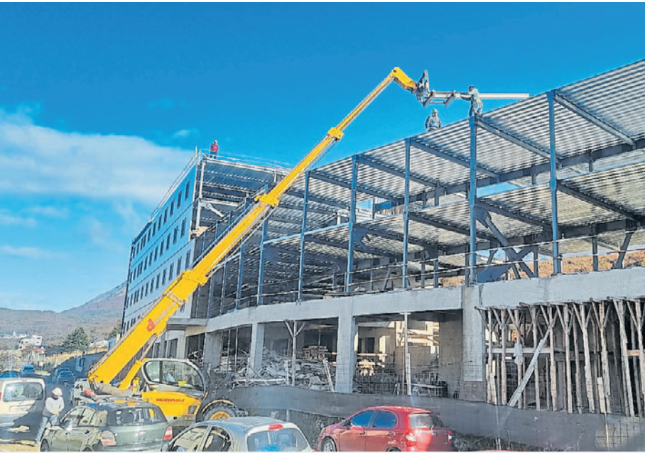
IN SITU. La mayor parte de los materiales se fabrican en talleres y se montan en obra.
