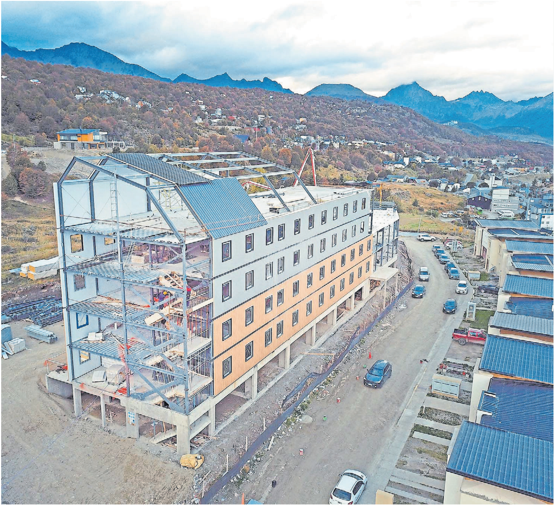
ESTRATEGIA. Dado que las condiciones climáticas permiten trabajar en el exterior solo noviembre a marzo, se empezó por las fundaciones, la estructura y la piel del edificio.
