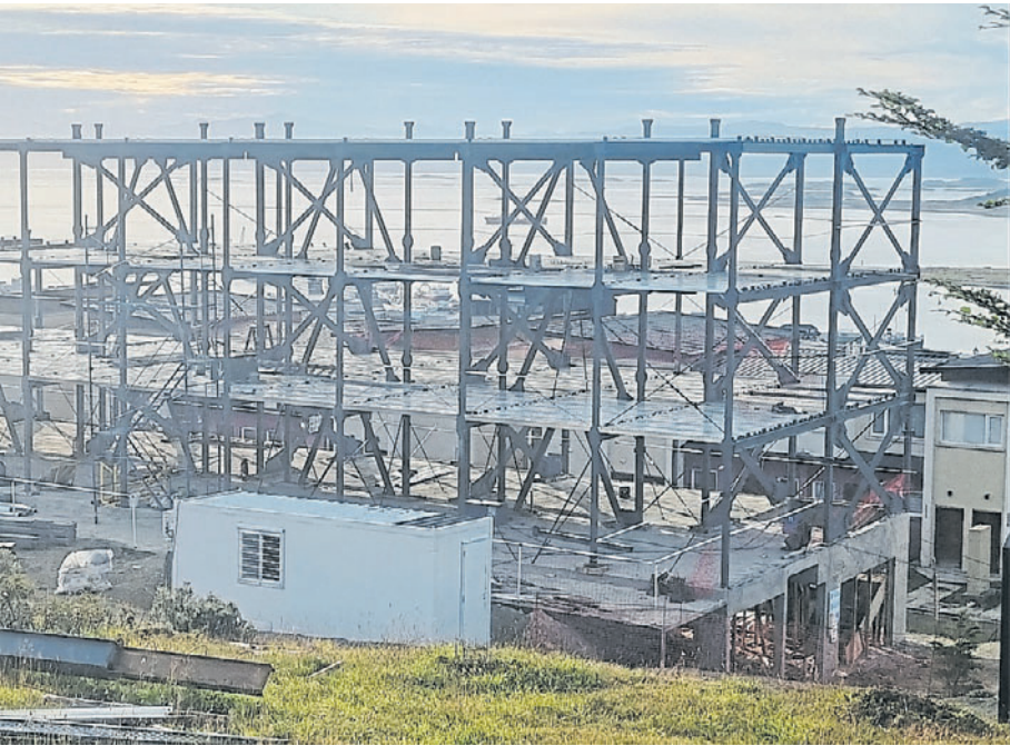
METÁLICA. La estructura del edificio se realizó luego de las fundaciones de hormigón..
